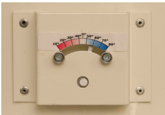
Rysunek 3. Zadajnik kąta obrotu łopatek.
